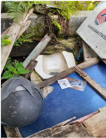
Bekas bangunan WC
