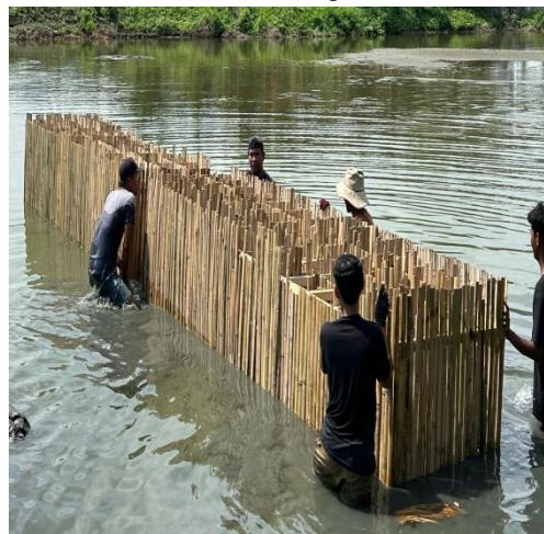
Gambar 6. Pemasangan kurungan di tambak
