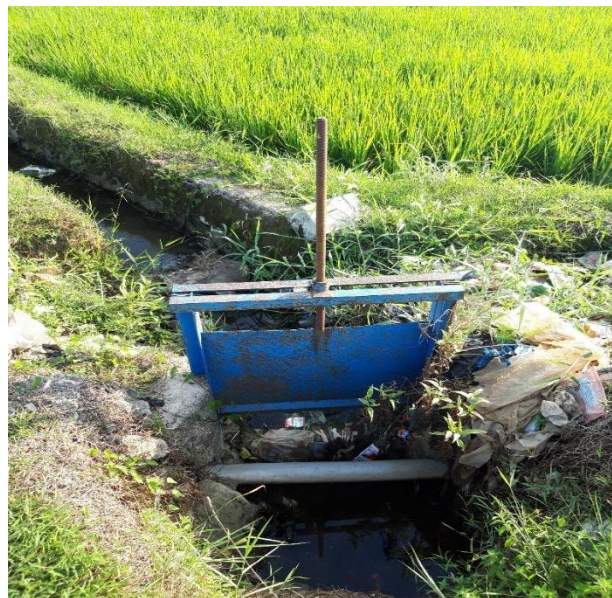
(Pintu pengairan dan saluran tersier pada skala kecil yang langsung mengalir lahan persawahan. Sumber: Dokumentasi Pribadi diambil pada tanggal 14 Juni 2023).
