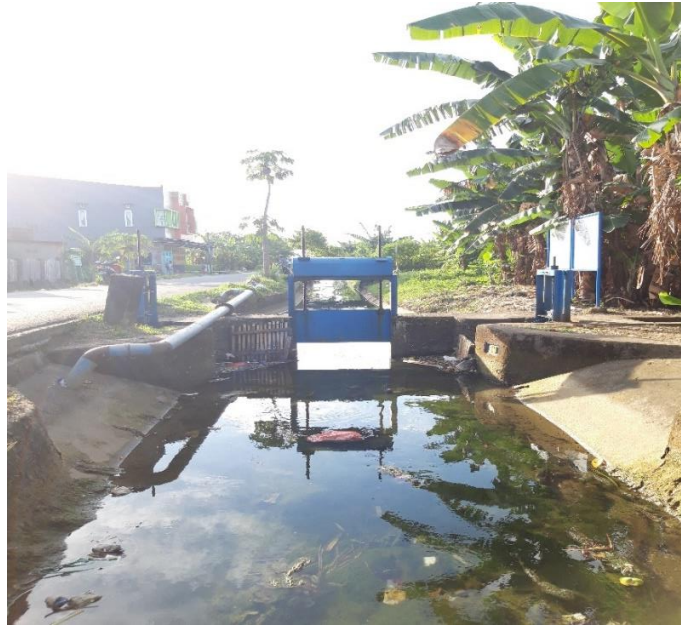
(Pintu pengairan dan saluran tersier di subranting Maros Baru. Sumber: Dokumentasi Pribadi diambil pada tanggal 14 Juni 2023).
