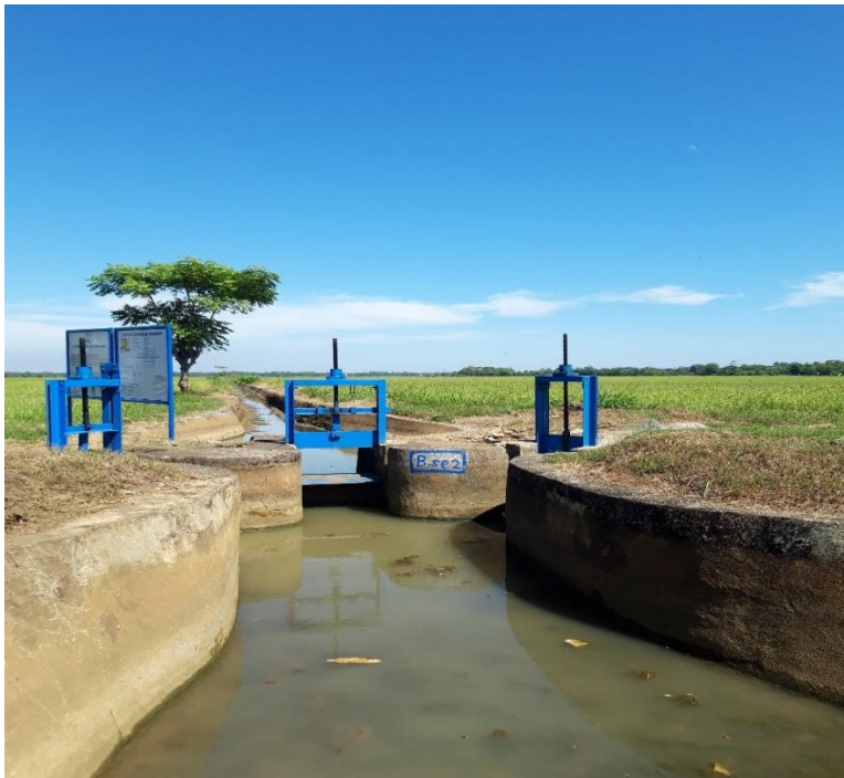
(Pintu pengairan saluran sekunder Sambueja di Kecamatan Simbang pada Intake Kiri D.I. Bantimurung. Sumber: Dokumentasi Pribadi diambil pada tanggal 14 Juni 2023).
