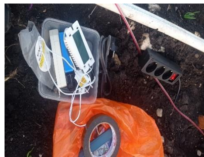
Gambar 7. Perakitan instalasi perangkat
