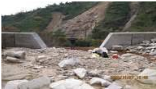
Gambar 2. Check Dam Tipe Tertutup
