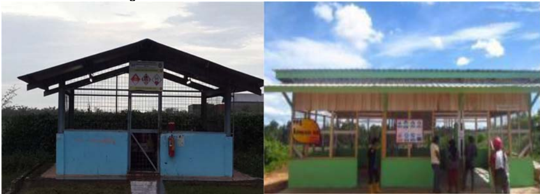
Lampiran 6. Tempat Pembuangan Sementara (TPS) LB3 Pabrik Kelapa Sawit 1 dan Estate C PT. Bio Inti Agrindo
