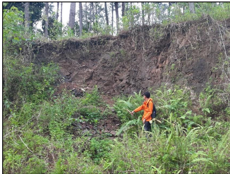
Gambar 2. 16 Kenampakan debris fall difoto dengan arah N 43°E dekat stasiun 15
