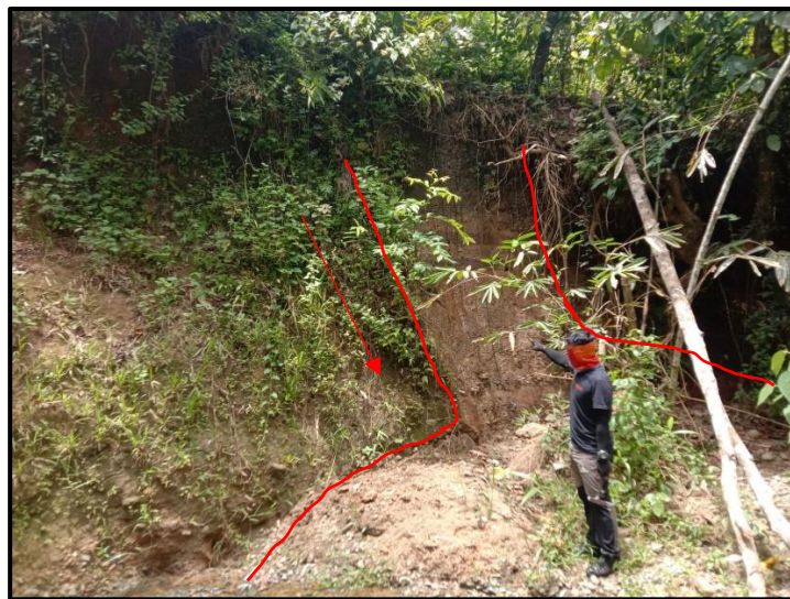
Gambar 7 Kenampakan debris slide pada stasiun 21 dengan arah foto N151°E
