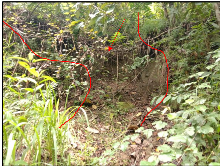
Gambar 13 Kenampakan debris slide pada stasiun 19 dengan arah foto N202°E
