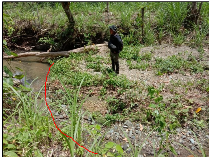
Gambar 21 Kenampakan point bar pada sungai Sunaba dengan arah foto N 44°E
