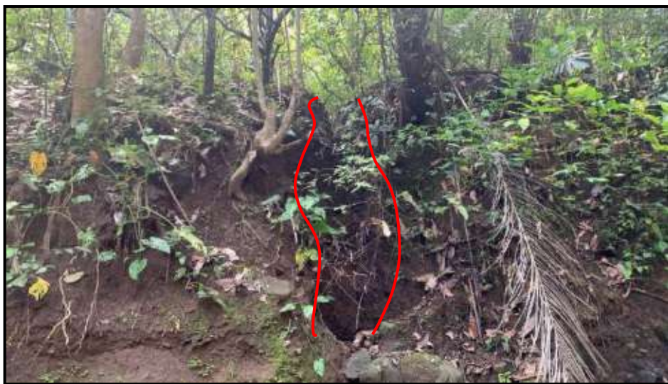
Gambar 2. 4 Gully erosion pada stasiun 31 difoto ke arah N312°E
