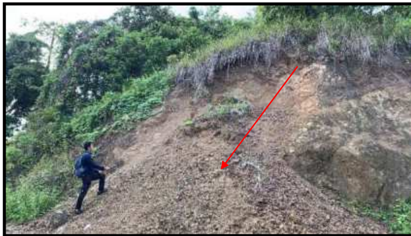
Gambar 2. 5 Debris slide pada Stasiun 22 difoto ke arah N104°E
