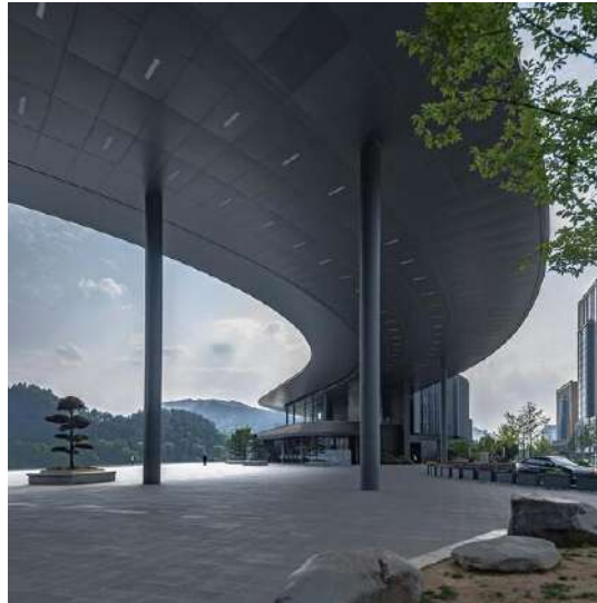
Gambar 2. 43 Atap Bangunan Jiande Cultural Center
