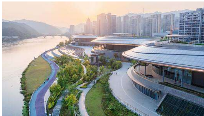
Gambar 2. 40 Bangunan Jiande Cultural Center
