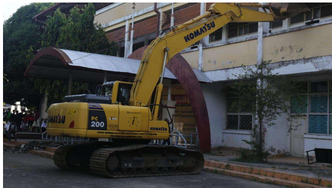
Gambar 2 Dokumentasi pembongkaran Stadion Andi Mattalatta
