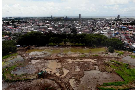
Gambar 3 Kondisi Eksisting Stadion Andi Mattalatta
