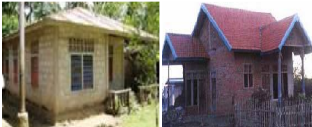
Gambar 5. Bangunan rumah yang terbuat dari pasangan bata
