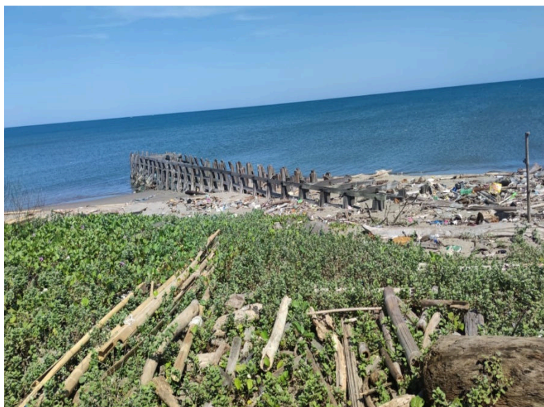
Gambar 2. Struktur untuk penanganan abrasi akibat arus sejajar pantai dengan groin permeable
