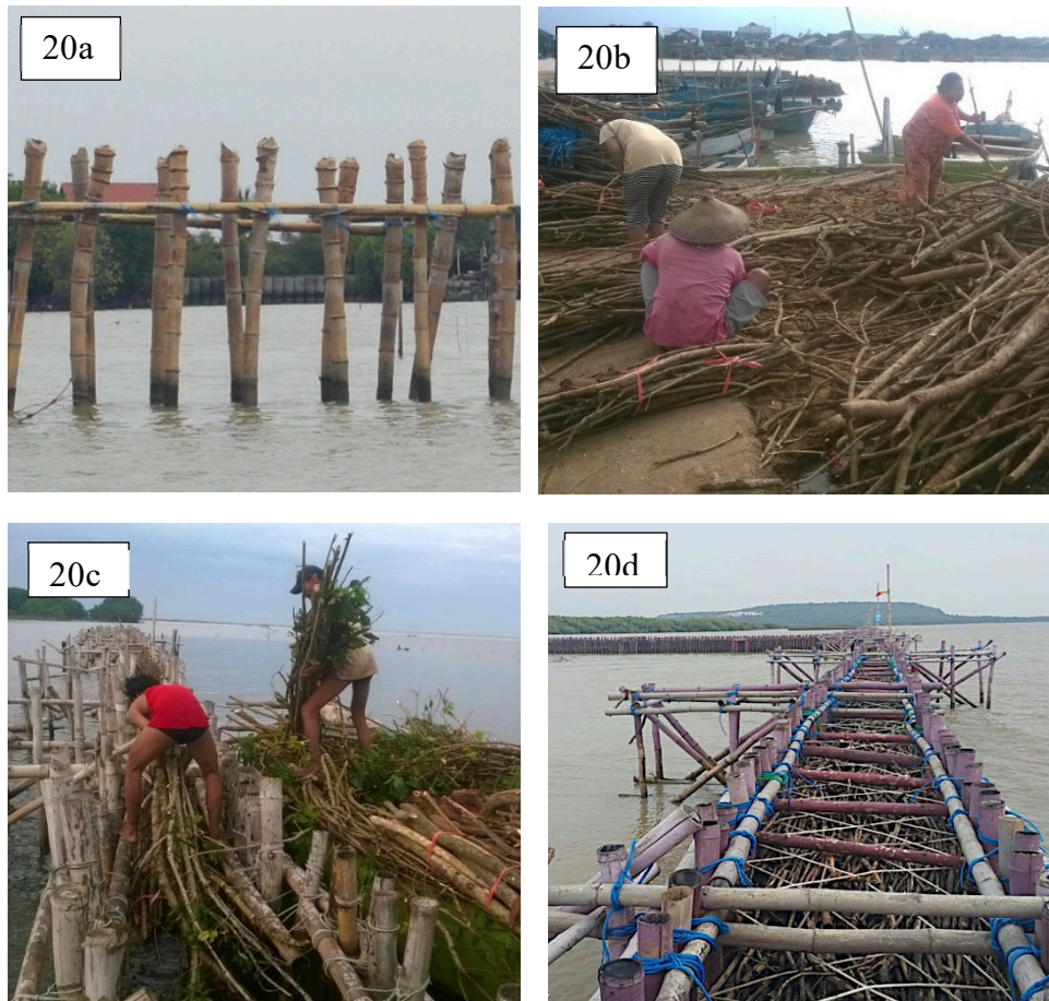
Gambar 20. a) Susunan pancang bambu sebagai dasar struktur HE, b) Pemilihan ranting pengisi struktur HE c) Proses pengisian ranting di struktur HE d) Struktur HE yang sudah selesai dan siap digunakan Sumber Gambar: Ecoshape Consortium , 2016
