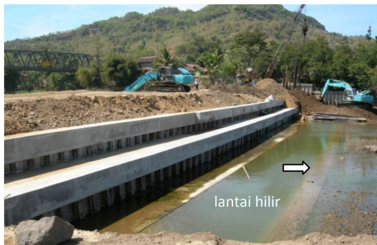
Gambar 3. Struktur ambang dasar ( grundsill ) untuk mencegah gerusan pada pilar jembatan
