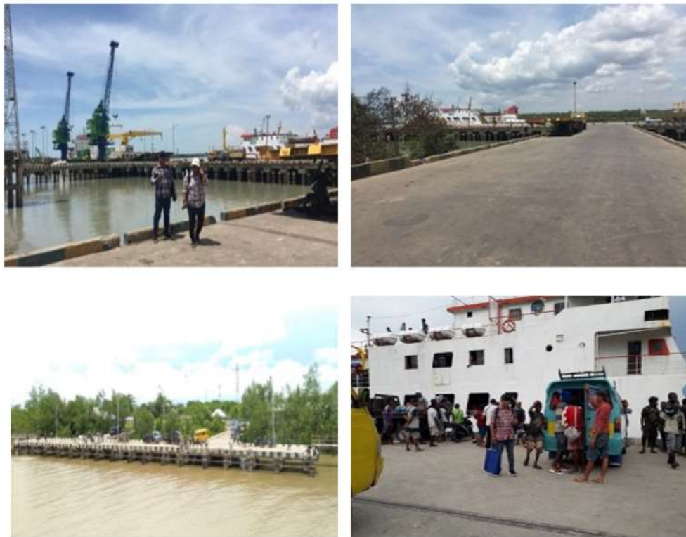
Gambar 39. Dermaga Beton Pelabuhan Merauke dan Pelabuhan Kelapa lima
