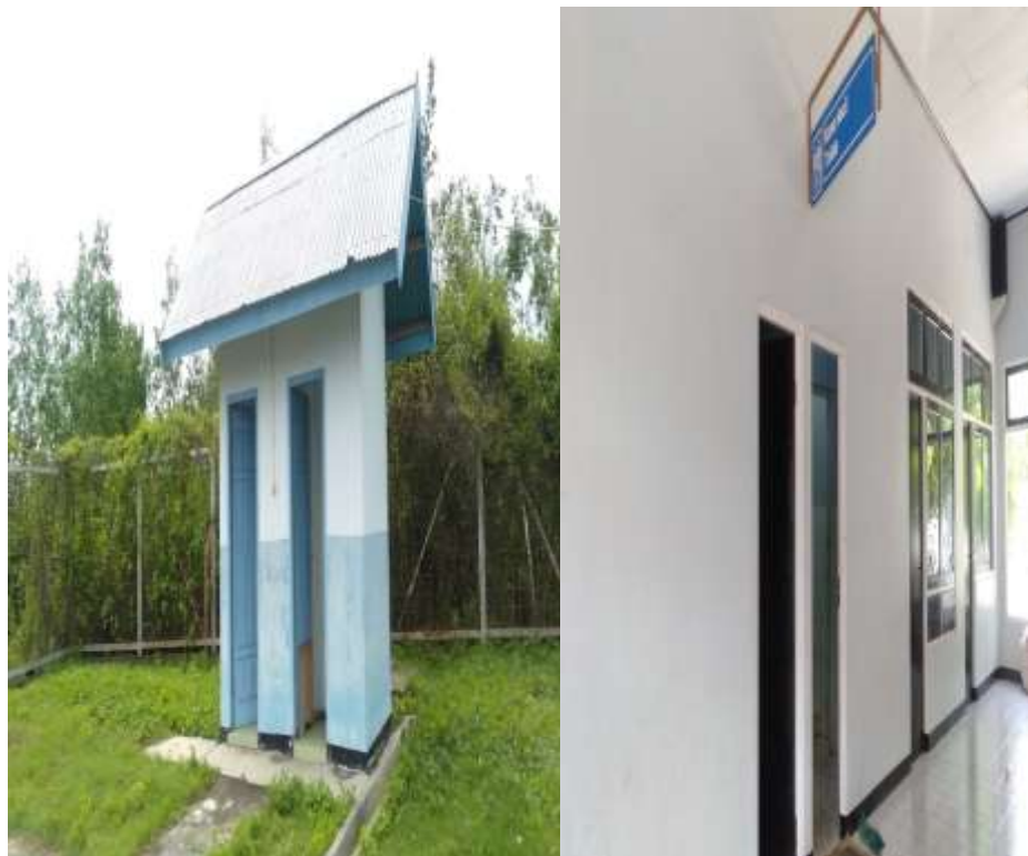
Gambar 41. Toilet Pelabuhan Merauke dan Pelabuhan Kelapa Lima
