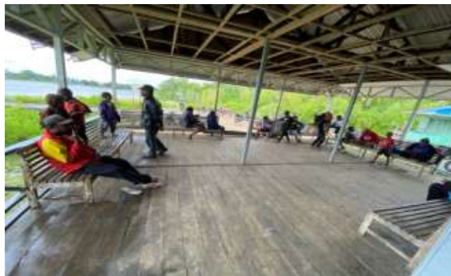
Gambar 22. Ruang Tunggu di Kumbe 1
