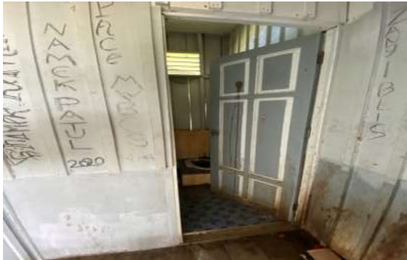
Gambar 21. Fasilitas Toilet di Kumbe 2
