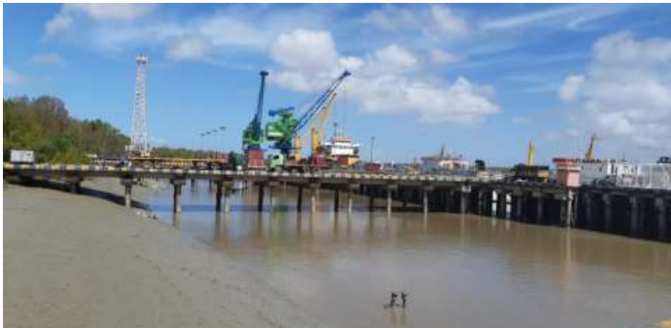
Gambar 36. Dermaga Beton Pelabuhan Merauke
