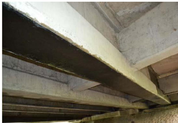
Gambar 1 Perkuatan Girder Jembatan menggunakan Lembaran FRP
