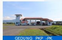
GEDUNG PKP -PK
