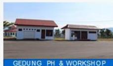
GEDUNG PH &amp; WORKSHOP
