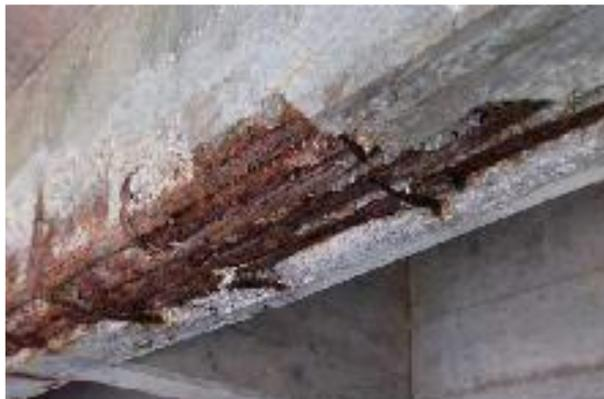
**Gambar 1.** Spalling pada beton bertulang akibat korosi
