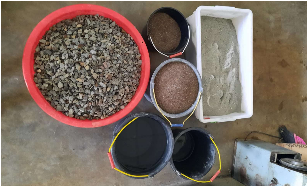
Persiapan Material Pengecoran
