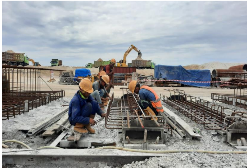
Proses Perakitan Tulangan Pada Bekisting (Sumber: Hasil Pengamatan)
