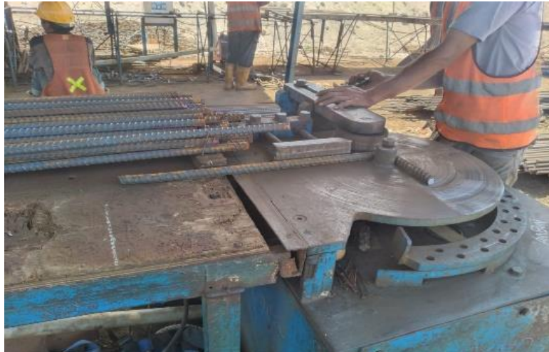
Proses Pembengkokan Tulangan Besi (Sumber: Hasil Pengamatan)
