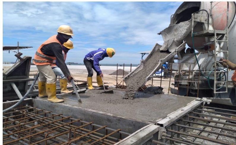
Proses Pengecoran Precast (Sumber: Hasil Pengamatan)
