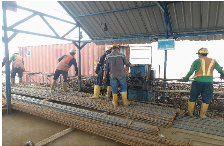
Proses Pemotongan Tulangan (Sumber: Hasil Pengamatan)
