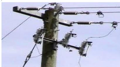
Gambar 13 Contoh Letak Pemasangan *Fused Cut Out (FCO)* dan *Load Break Switch (LBS)* (Hasanuddin dan Fadli, 2019)
