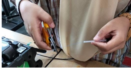
Gambar 14 Pengelupasan cladding
