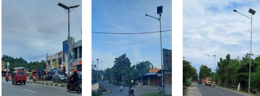
Gambar 2.10. Jenis Penerangan Jalan Umum Tenaga Surya di Kabupaten Manokwari
