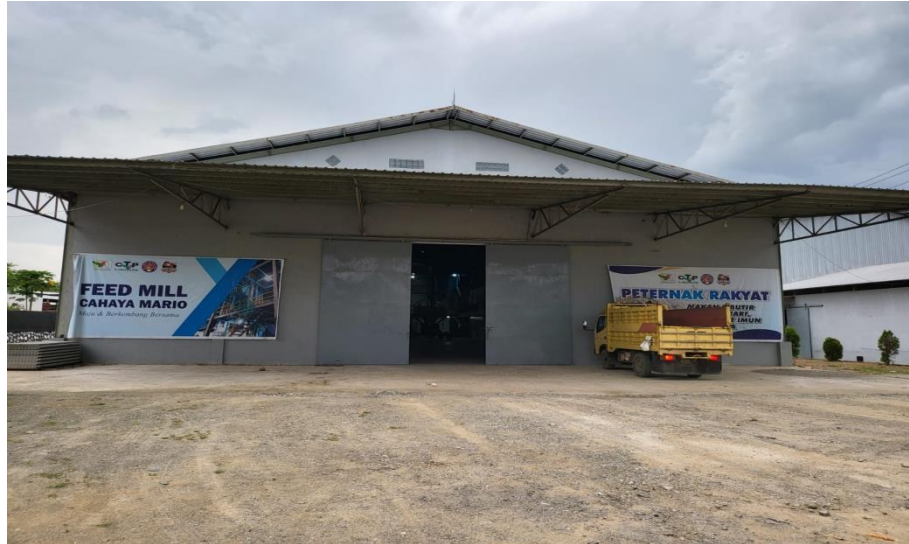
Gambar 1. Tampak Depan Pabrik Pakan CV. Cahaya Mario
