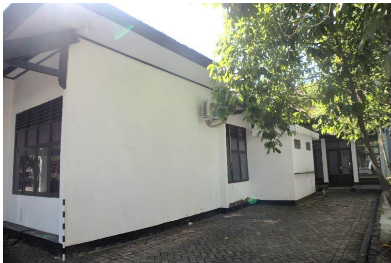
Foto 8. Kantor Controleur Belanda Tampak Timur (Dok. Lia Islamiah, 2019)
