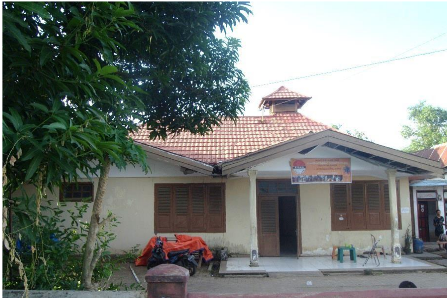
Foto 11. Kantor Pemerintahan Belanda Tampak Depan (Dok. Lia Islamiah, 2019)
