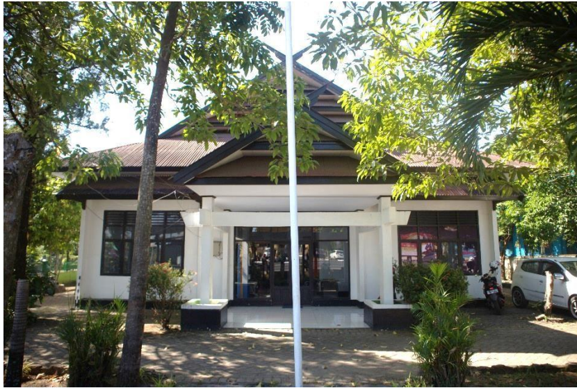
Foto 7. Kantor Controleur Belanda Tampak Depan (Dok. Lia Islamiah, 2019)
