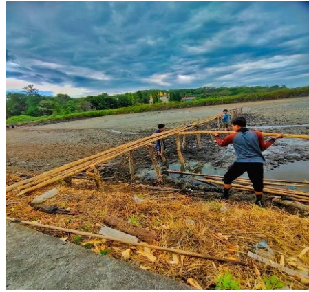
(Proses pemasangan bambu jembatan)
