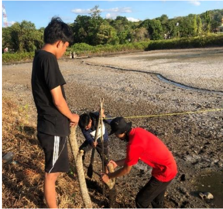
(Proses pembuatan jembatan)
