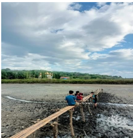
(Proses pembuatan jembatan)
