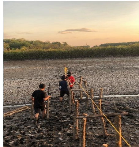
(Proses pembuatan jembatan)
