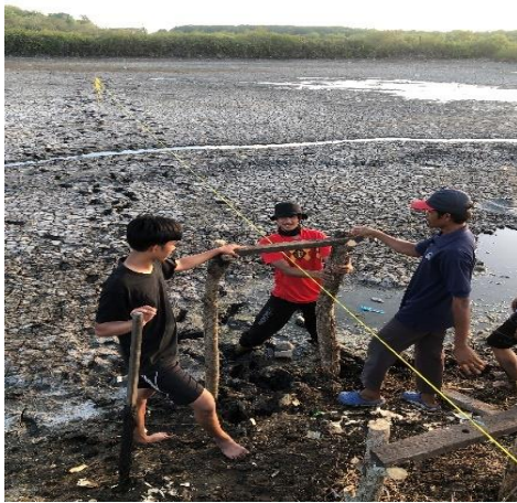
(Proses pembuatan jembatan)
