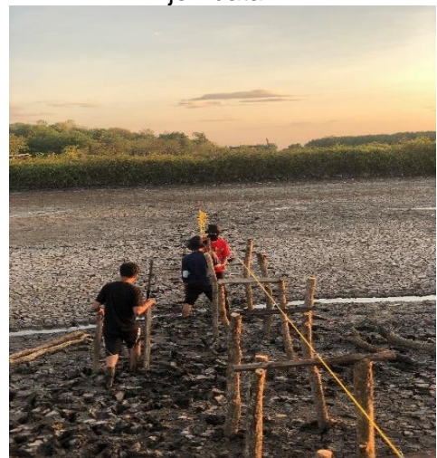
Proses pembuatan jembatan
