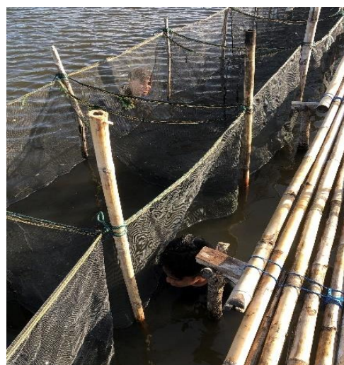
Proses pemasangan hapa
