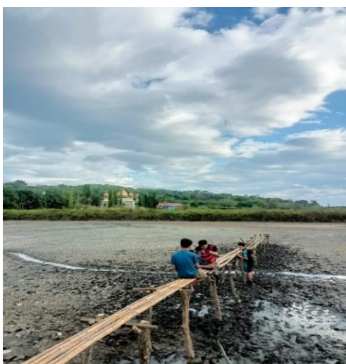
Proses akhir dari pembuatan jembatan
