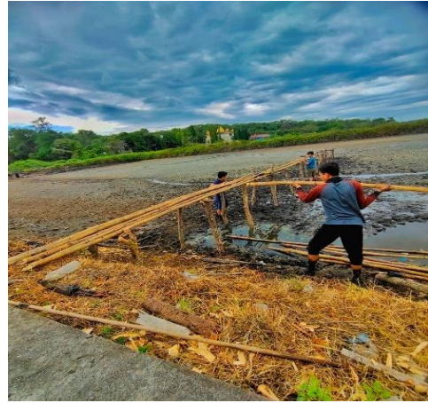
Proses pemasangan bambu untuk jembatan
