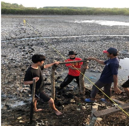
Proses pembuatan jembatan
