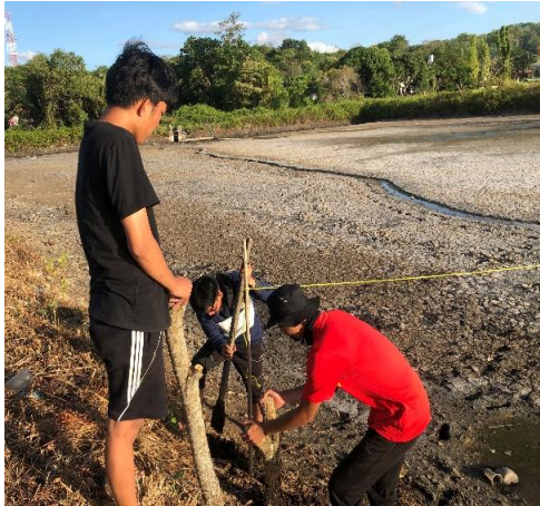
Proses pembuatan jembatan
