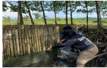
Gambar 2. Pemasangan waring pada kurungan
