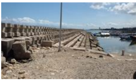
Breakwater sisi Barat
