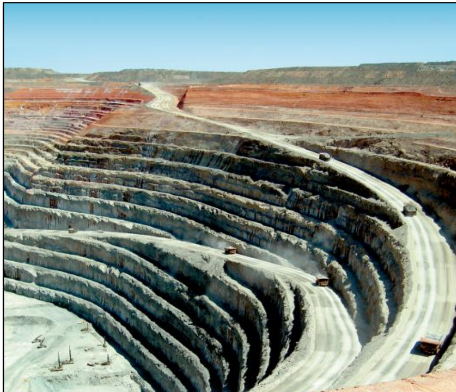
Gambar 2.1 Lereng buatan pada tambang terbuka (Read & Stacey, 2009)
