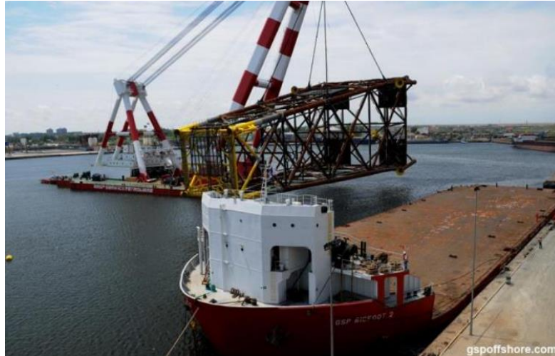
Gambar 2.3 Proses lifting menggunakan crane [2]
