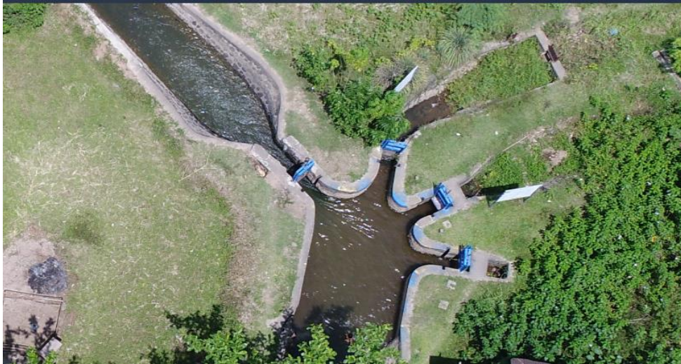
Gambar 15. Pintu Tersier yang Diperoleh dari Saluran Sekunder yang Membagi ke Saluran Tersier
