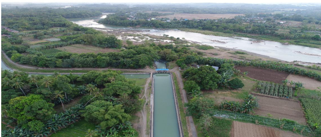
Gambar 8. Pintu Pembuang, Penguras Lumpur dan Pintu Saluran Induk (Primer) Daerah Irigasi Kampili
