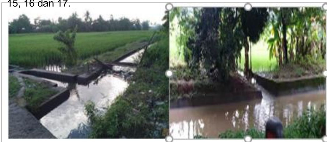
Gambar 13. Saluran tersier tanpa pintu
