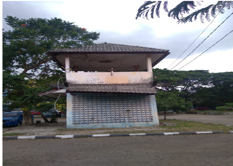
Gambar 1. Gudang dan Ruang pengawas
