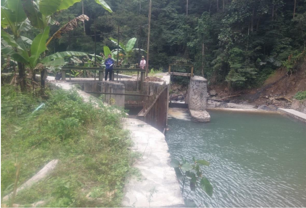
6. Pintu masuk air dari sungai ke bendungan PLTM
