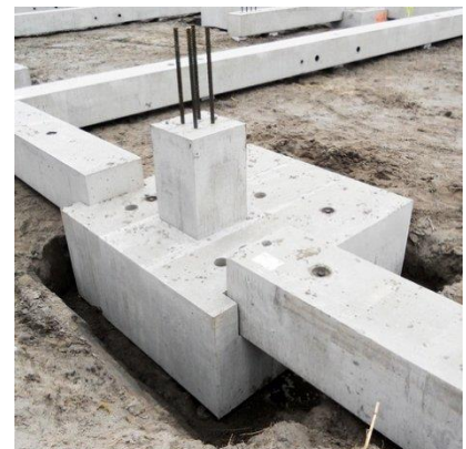
b. Pile cap dan tie beam
