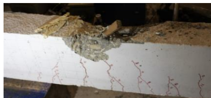
b. Pola retak pada kegagalan balok R-75-R
