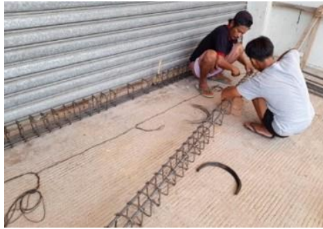
(a) Perakitan Tulangan
