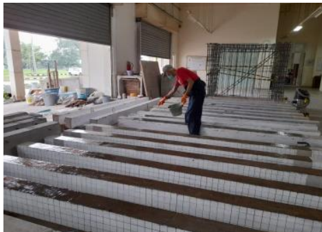
(e) Mengoleskan Epoxy Resin
