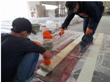
(c) Mengoleskan Epoxy Resin
