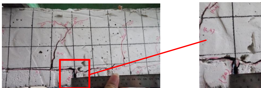
Gambar 53. Pengukuran Lebar Retak Balok BGR
