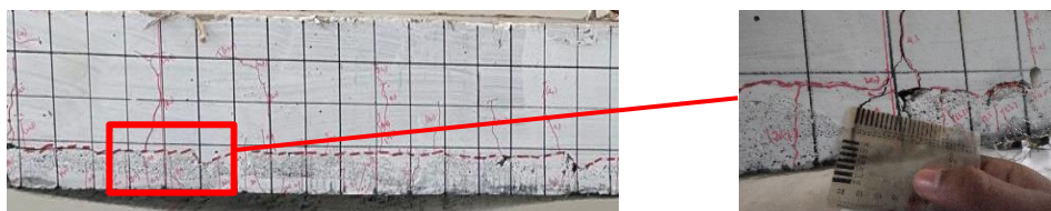
Gambar 57. Pengukuran Lebar Retak Balok BGRF-S
