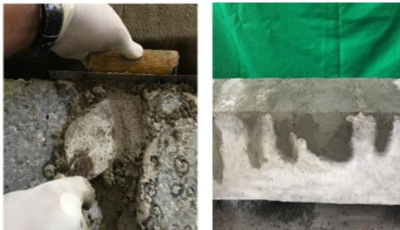
**Gambar 1.** Proses perbaikan mortar geopolimer pada balok
