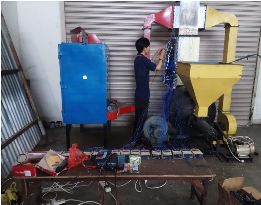
Gambar B10 : Pemasangan dudukan ke mesin pengering rak telur
