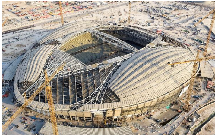
Gambar 15. Proses Konstruksi Al Janoub Stadion
