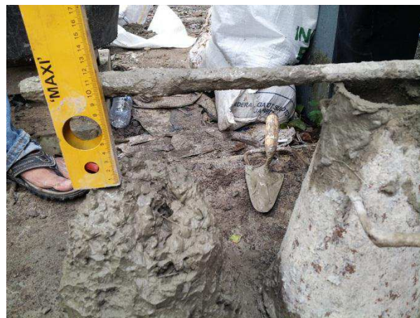
Pengujian Nilai Slump
