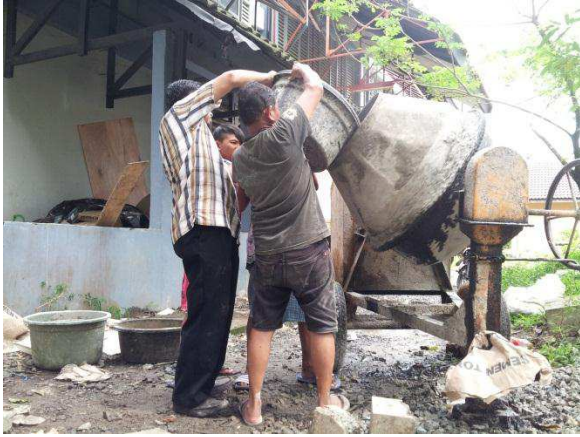
Pencampuran Material Beton
