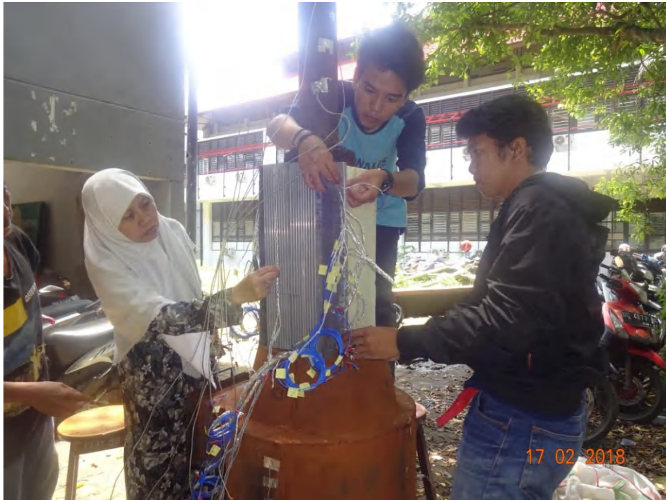
Gambar 1. Pemasanganudukan TEG pada cerobong bawah insinerator
