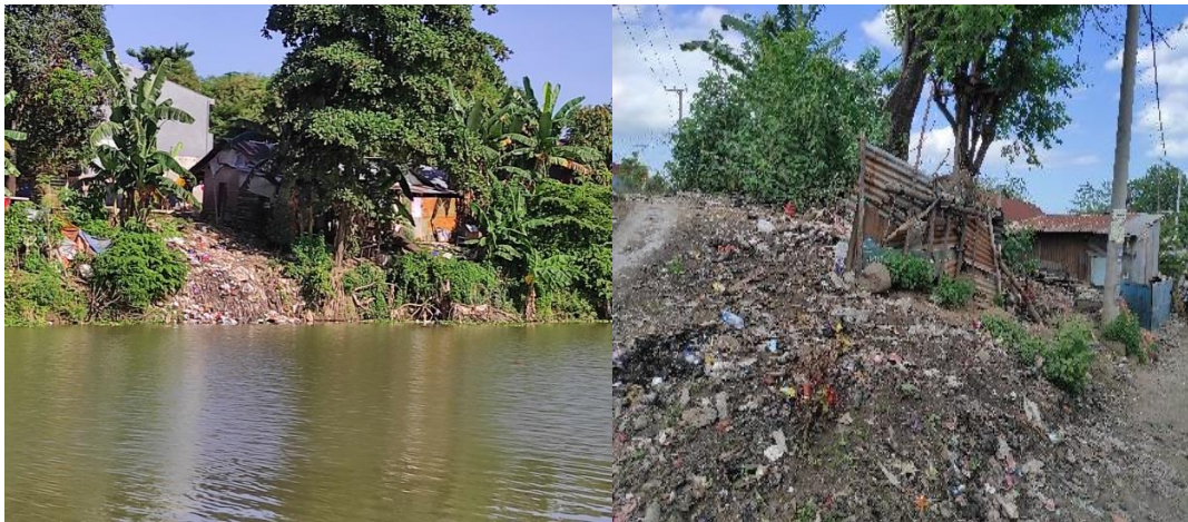
Gambar 7. Kondisi Eksisting pada Stasiun 2
