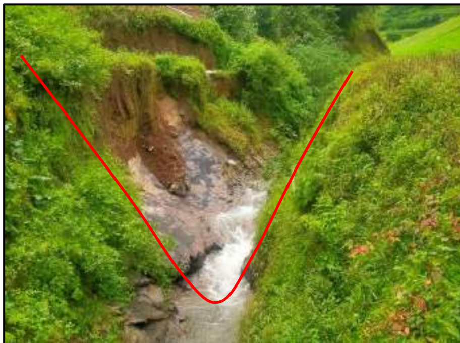
Gambar 2.25 Kenampakan penampang sungai “V” batang dengan arah aliran N57^{\circ}E pada Stasiun 43.
