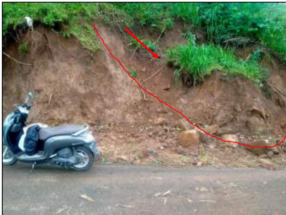
Gambar 2.16 Kenampakan debris slide dengan arah foto N102° E pada Stasiun 3.
