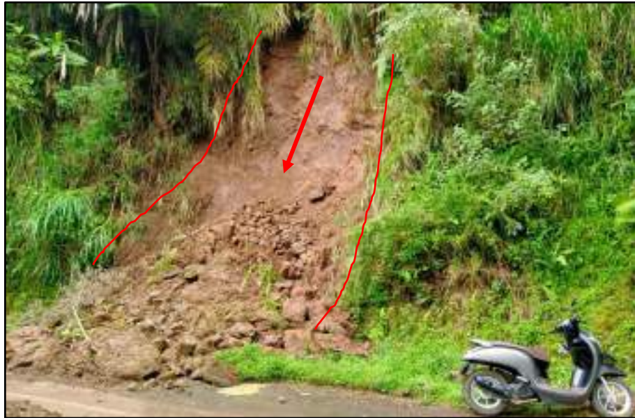
Gambar 2.15 Kenampakan debris fall dengan arah foto N186° E pada Stasiun 3.
