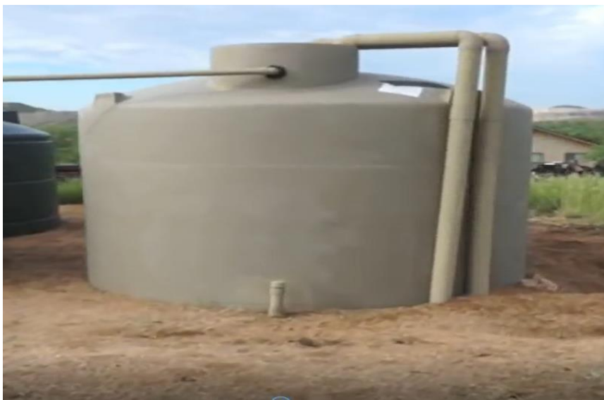
Gambar 2.12 Tangki Penampungan (Kapasitas 5000 galon)
