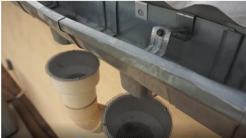
Gambar 2.10 Saluran yang Mengalirkan Air Hujan dari Atap dan Rang Besi sebagai Filter pada Pipa
