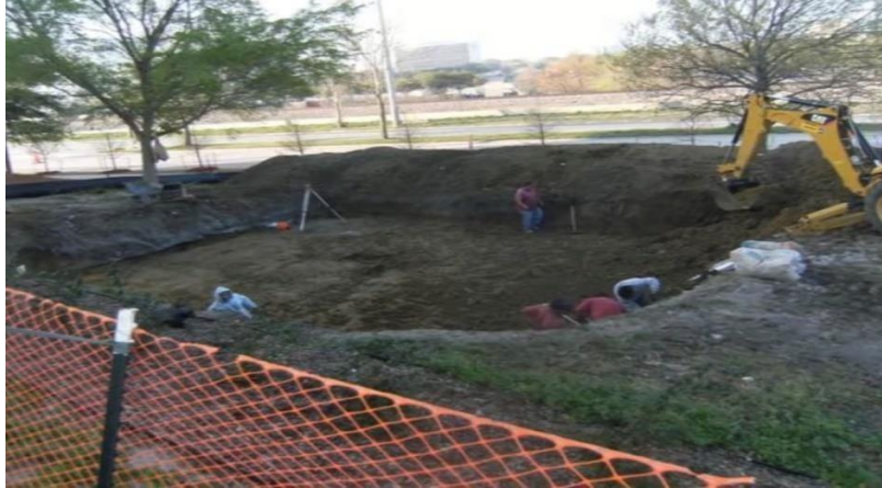
Gambar 2.7 Persiapan Petak Tanah sebagai Tempat Underground Rain Water Harvesting
