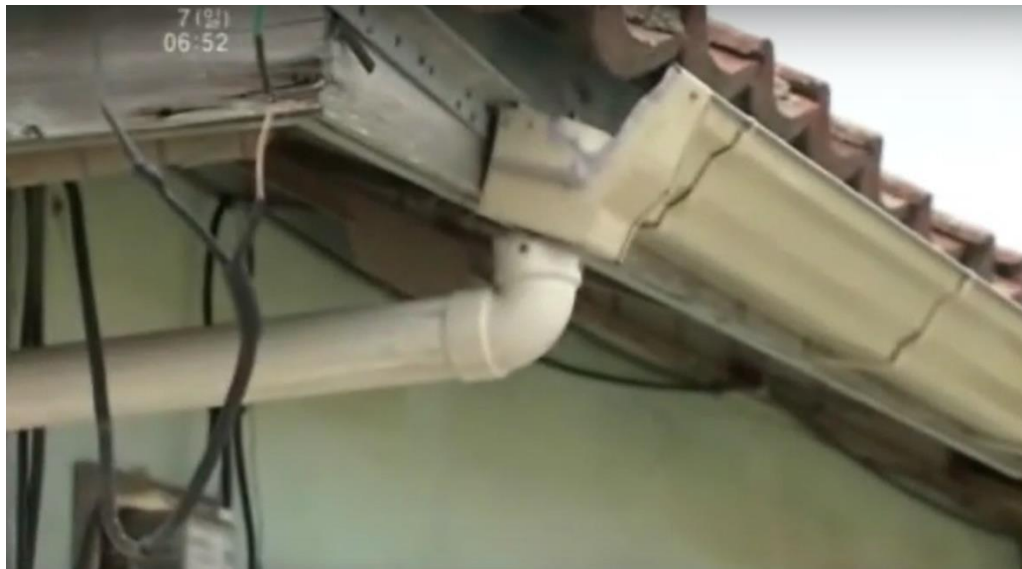
Gambar 2.14 Saluran Air Hujan
