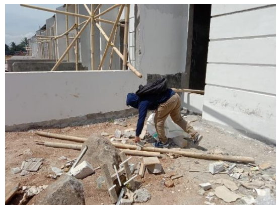
Pengumpulan Limbah Gypsum Board Dari Sisa Konstruksi Bangunan
