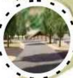
Pengerasan Jalan Aspal
