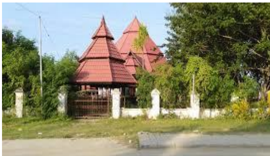
Kantor LMA namun dalam kondisi rusak
