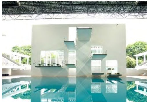
Gambar 2.4 Kolam dan Menara Loncat Indah di Stadion Akuatik GBK Sumber: www.gbk.id , 2021
