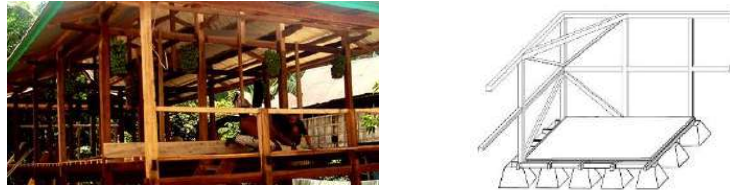
Gambar 11. Struktur Rangka Pada Rumah Adat Traditional Bugis
