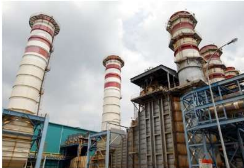
Gambar 2. 1 PLTGU Blok 2 Sengkang
